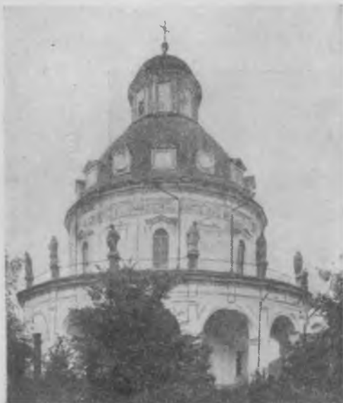
Рис. 51. Церковь в Подмоклом
